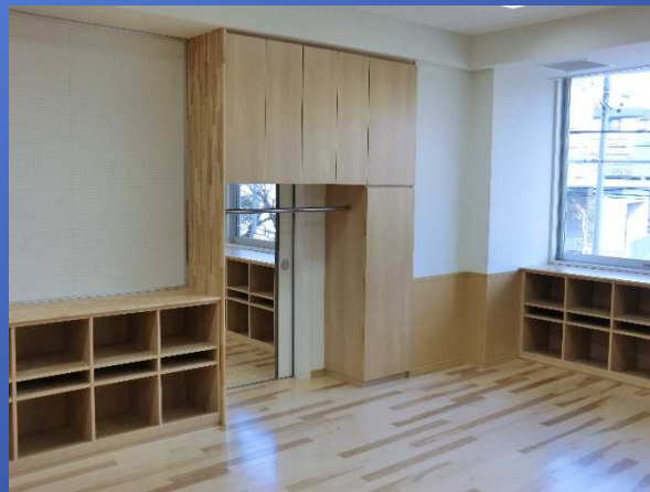
教室吊戸棚(避難口兼用)
