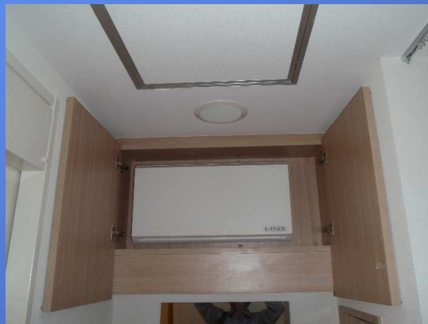
分電盤収納(内部)
