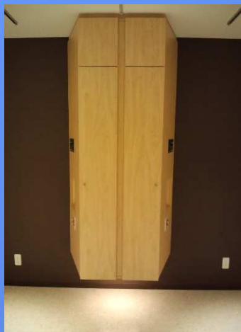
病室コンソール(両面)
